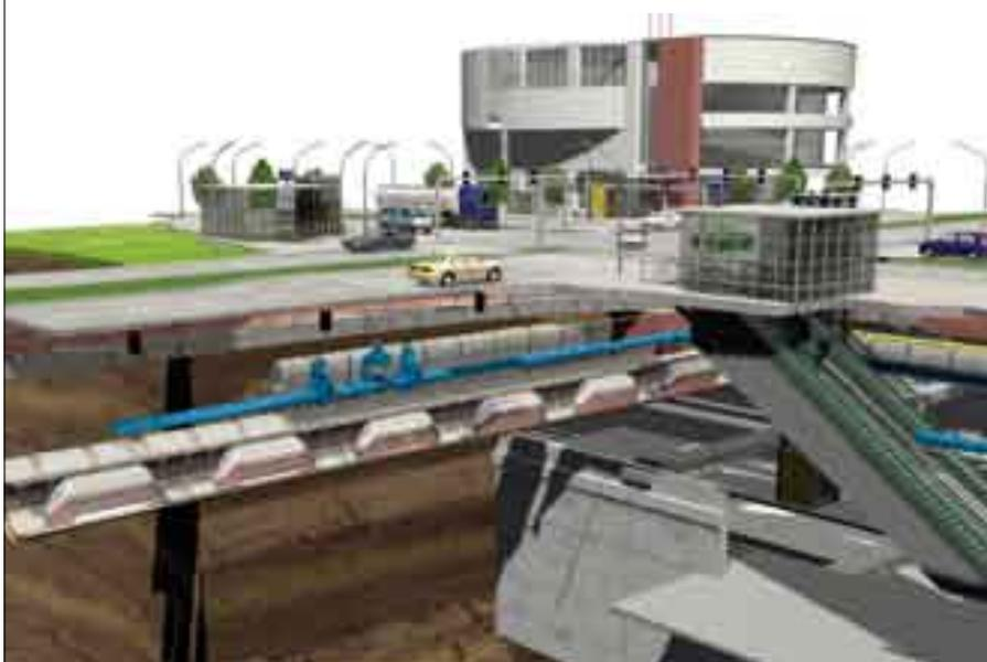
◀ **Simulation du réseau CARGO CAP de transport de marchandises en souterrain.**
